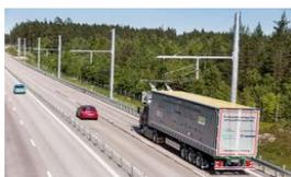
Parfait mélange entre voie de chemin de fer et autoroute, la route électrique E6 a été inaugurée en date du 22 juin 2016, en Suède. Cette construction suédoise, implique l'installation de câbles au-dessus de la voie de droite sur un tronçon de deux kilomètres.
